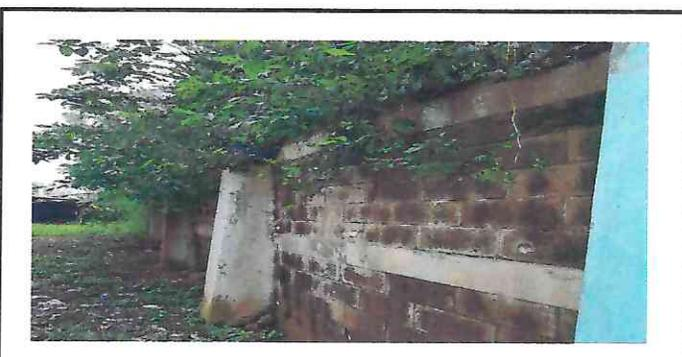
Foto 3: *Muro perimetral en mal estado*
